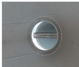
De vlinderklep wordt in een metalen ventilatiekanaal met dezelfde diameter geplaatst en op haar plaats gehouden door een rubberen dichtingsring. Een smeltlood houdt de twee halve klepbladen open.
