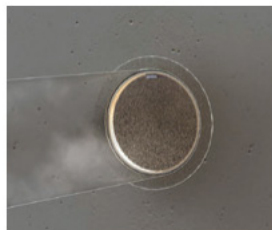
Wanneer de temperatuur in de luchtkoker 72°C bereikt, smelt het smeltlood en sluiten de twee delen van de klep.
