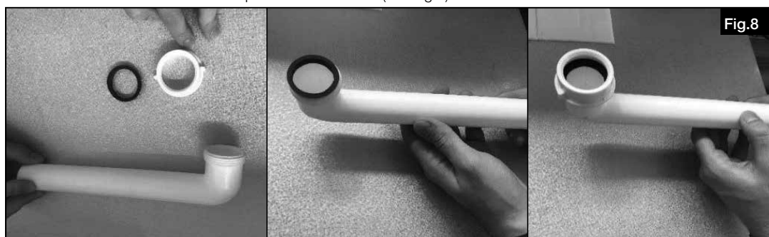
2. Fixer le coude du conduit sous le bac à condensat. S'assurer que la construction est étanche en faisant tourner le raccord (voir Fig.9).
