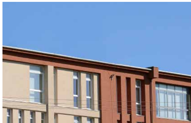
Geïntegreerde koeling in de luchtbehandelingskast, dus geen onaantrekkelijke installaties op het dak.
