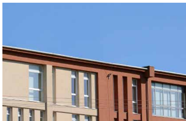
Geïntegreerde koeling in de luchtbehandelingskast, dus geen onaantrekkelijke installaties op het dak.
